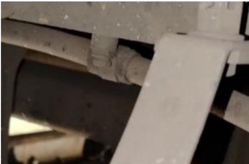
Рисунок Е.4 Установка прокладки под хомут
